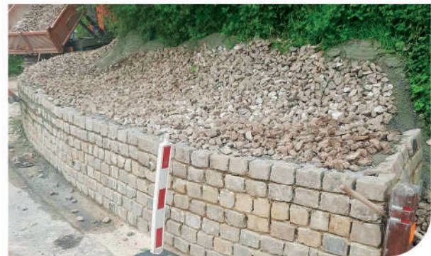
Travaux de lutte contre les coulées de boue
